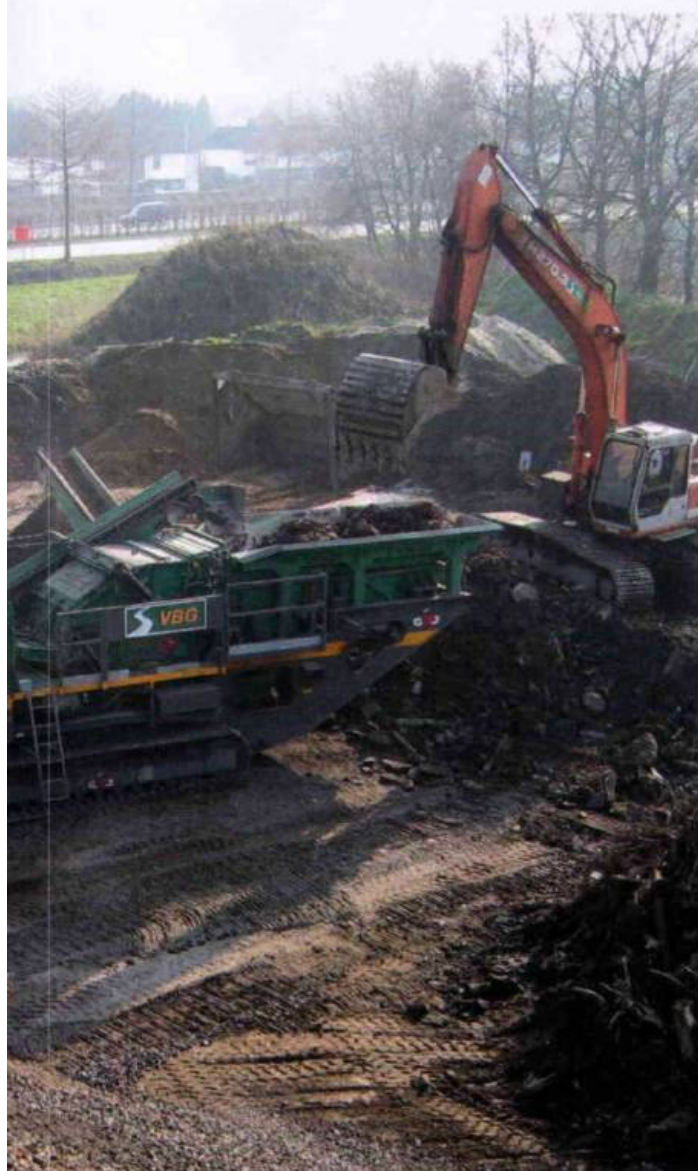
Engins mobiles pour déchets de construction et de démolition.
